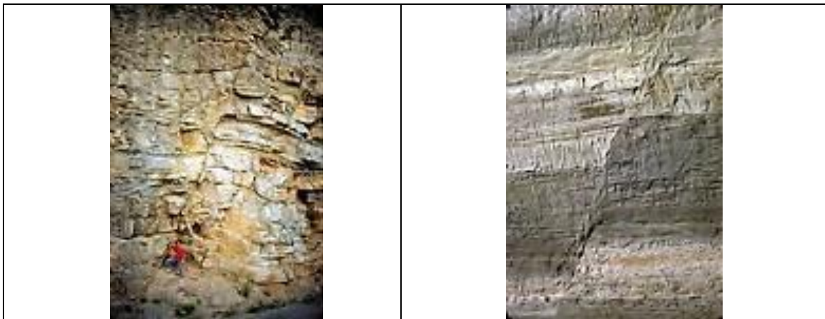
Fig. 19 Exemples de faille normale : a) dans des calcaires ; b) dans une formation sableuse
