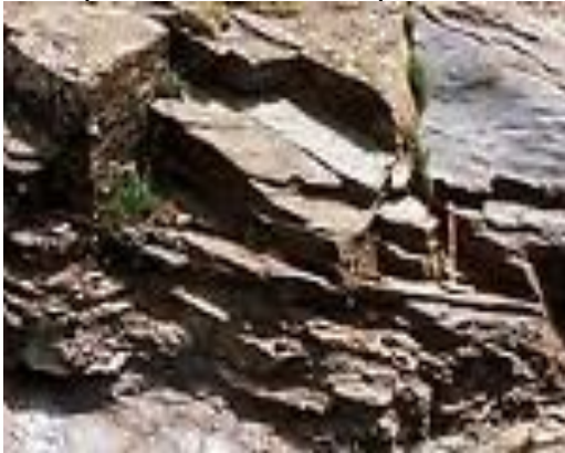
Fig. 20 Photo de massif de terrains schisteux
