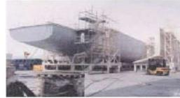
Coque de chasseur de mines- Moulage au contact en voie humide (120-150 t de composites)
