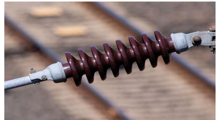
Isolateur céramique utilisé pour supporter les câbles haute tension
