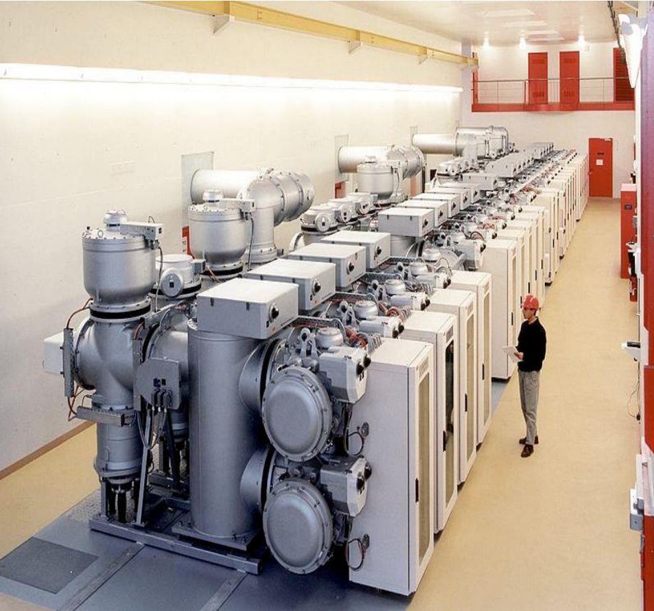
Poste électrique haute tension isolé au SF6
