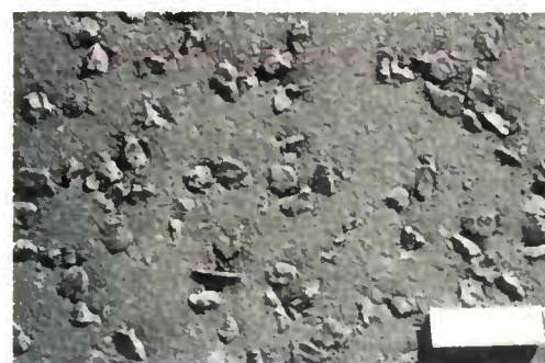
Sable enrobé clouté
