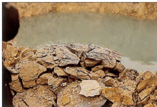
Le même bloc en cours de dégradation après plusieurs jours soumis aux intempéries.
