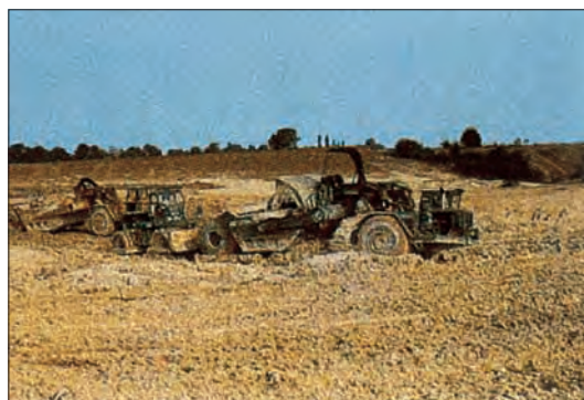
Craie de la classe R_{13,h} (craie de densité faible à teneur en eau élevée).
