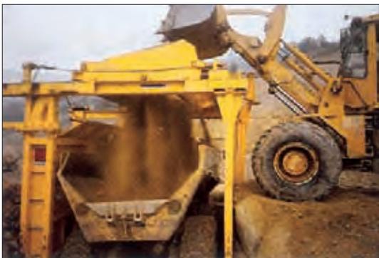
Chargement du crible.
