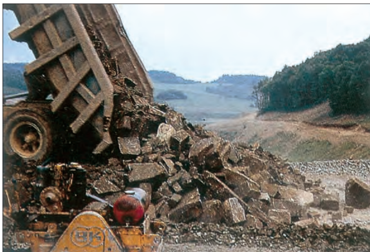
Roche magmatique dure (basalte) de classe R_{61}
