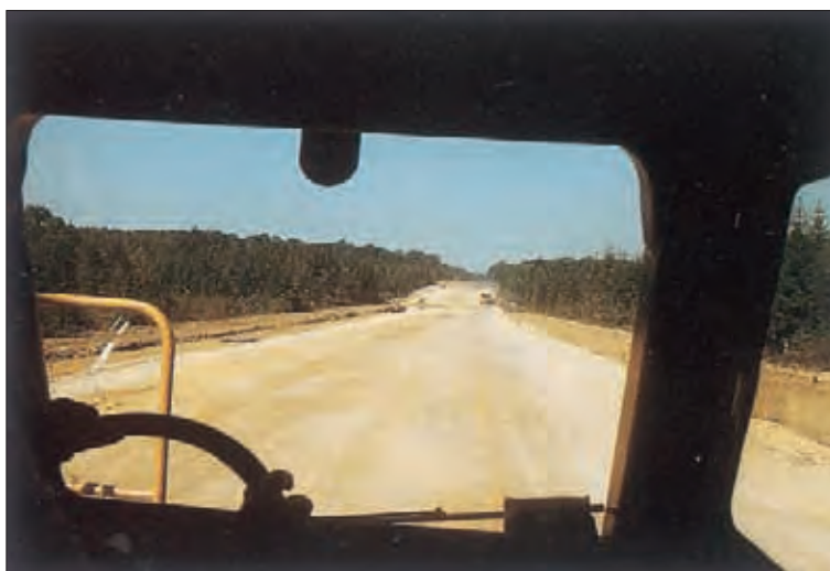
Une des fonctions "à court terme" primordiales de la couche de forme : assurer la circulation dans les meilleures conditions des engins approvisionnant les matériaux de la couche de fondation.
