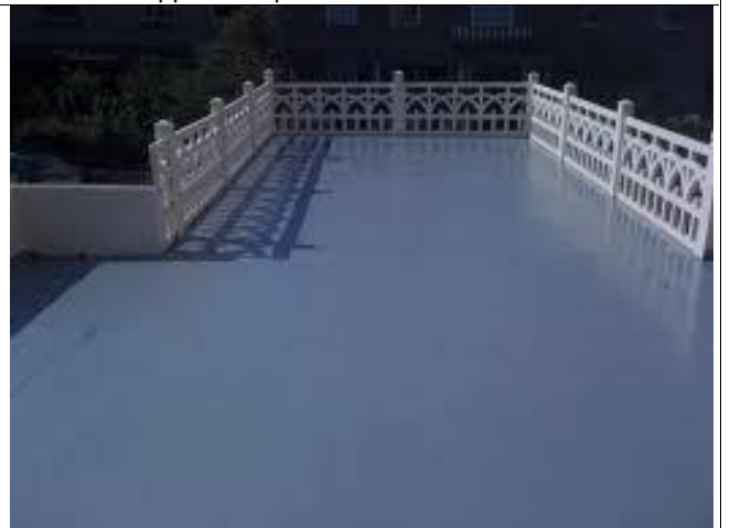
Etanchéité liquide d'une terrasse
