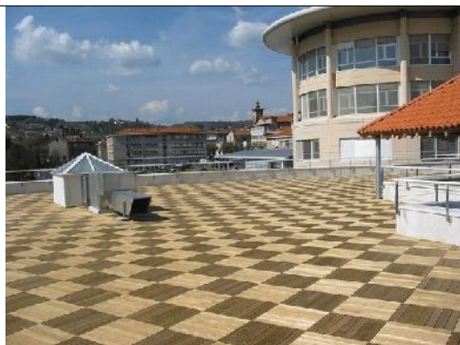
Toiture terrasse accessible
