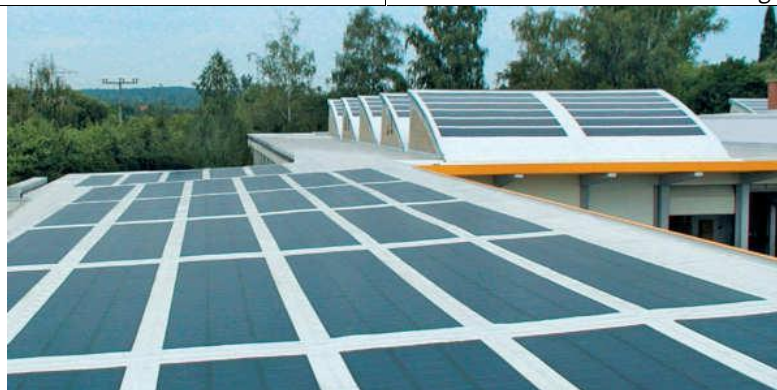
Nouvelles générations des membranes synthétiques d'étanchéité photovoltaïques qu'on peut poser sur les toitures plates, inclinées ou sur les dômes en remplacement des panneaux solaires, c'est joli et discret
