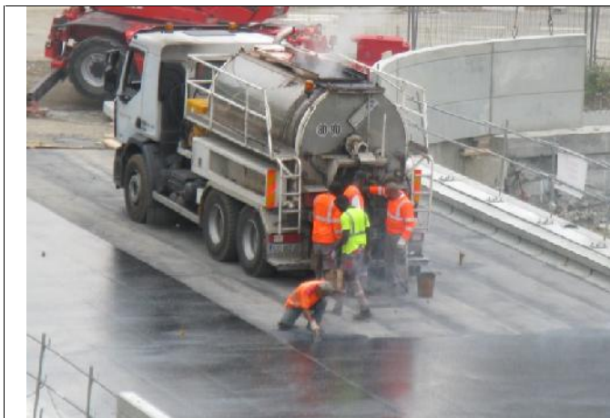
L'asphalte est transporté sur le chantier dans des pétrins mobiles installés sur des camions qui maintiennent sa température entre 180 et 220 degrés
