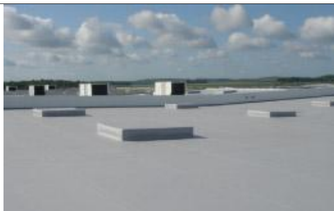
une terrasse revêtue d'une membrane synthétique
