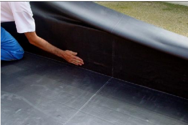
Pose au niveau des reliefs, là il s'agit d'une membrane EPDM auto-adhésive
