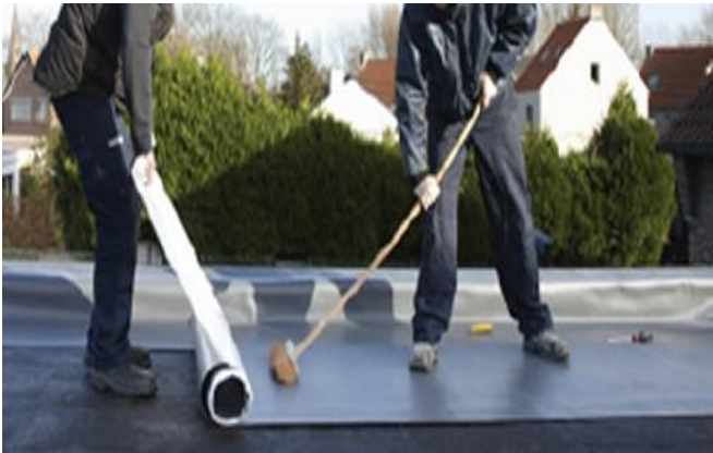
Pose d'une membrane auto-adhésive
