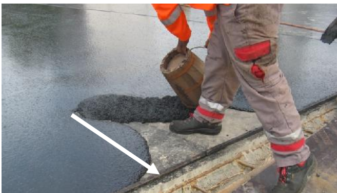
L'épaisseur est limitée à l'aide d'une réglette en bois
