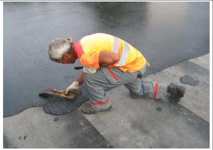
Puis étalé manuellement à l'aide d'une palette, également, en bois
