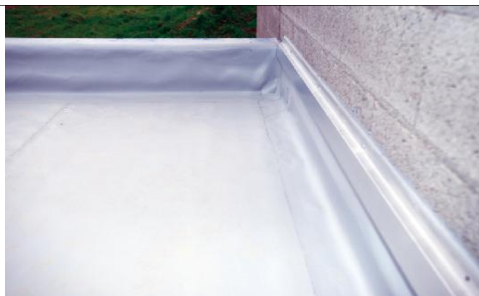
Membrane synthétique posée en vertical et fixé et protégée à l'aide d'une bande métallique
