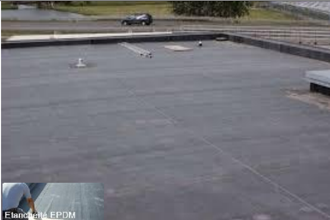
Terrasse revêtue d'une membrane synthétique en caoutchouc
