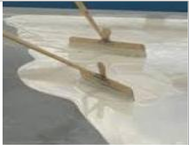
Application par étalement à la raclette
