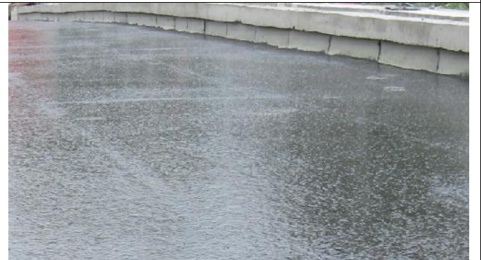
Une fois refroidi, on obtient un revêtement uniforme et lisse, totalement hermétique à l'air et à l'eau
