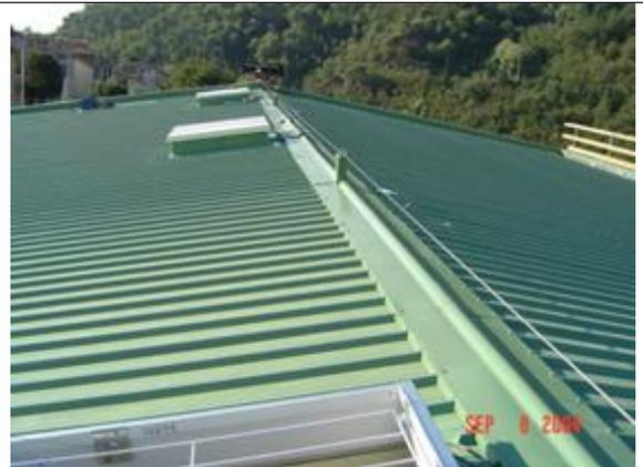
Toiture terrasse avec élément porteur en bac acier (charpente)
