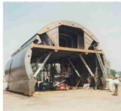
Remarque : réalisation de joints transversaux équipés au droit de chaque reprise de bétonnage
