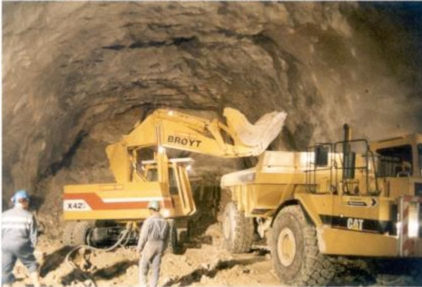
Lorsque les caractéristiques mécaniques du terrain sont telles que la stabilité des parois et du front ne peut être assurée si l'on procède en une seule fois à l'abattage de toute la section, on pourra alors adopter le creusement en section divisée.
